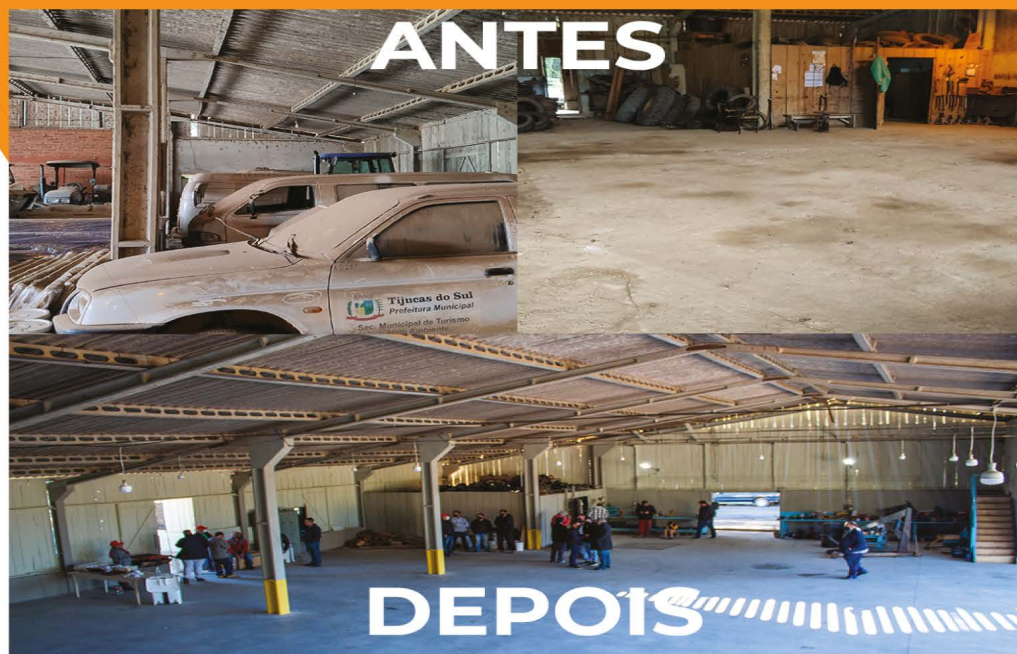
Reforma do Pátio de Máquinas
